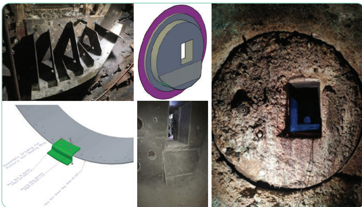
ภาพ การติดตั้งระบบป้องกันการตกระแทกของของเสียบนพื้นเตา
