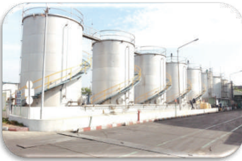
ภาพ Storage Tank สำหรับจัดเก็บสารเคมีที่เป็นของเหลว
