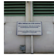
จุดที่ 2 ข้างอาคาร Drum
