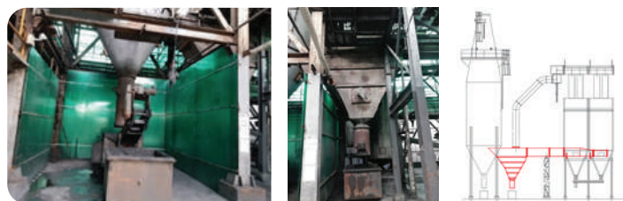
ภาพการติดตั้ง Sedimentation Tank และระบบระบายเก้าอี้แบบอัตโนมัติ
