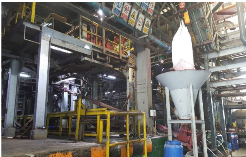
ภาพแสดง ระบบการป้อนเม็ดข้าวโพดเข้าเตาเผาอย่างต่อเนื่องโดยระบบ Screw
